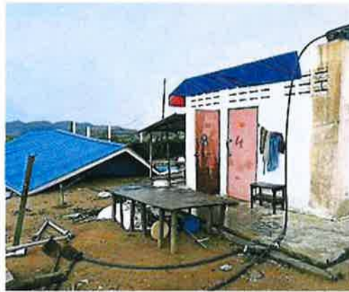
狂風的威力驚人，就連工人宿舍的屋頂也被吹飛
