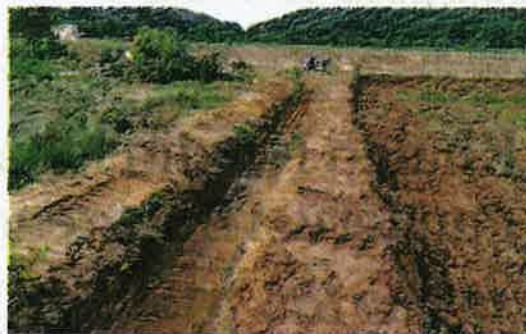
PROSES perataan tanah terbiar bagi membangunkan SMART SBB di Kampung Kulambai Kota Belud, Sabah.
