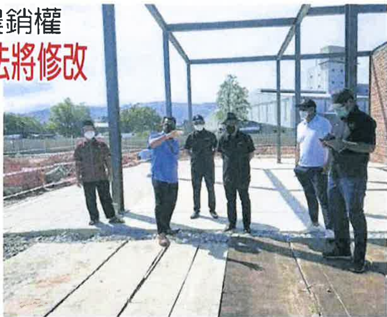
■罗南建迪（左4）视察施工中的沙巴水果加工中心。
