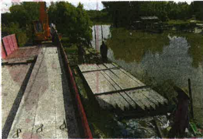
Kerja-kerja pembinaan jeti nelayan di Kampung Fikri Setlu.
