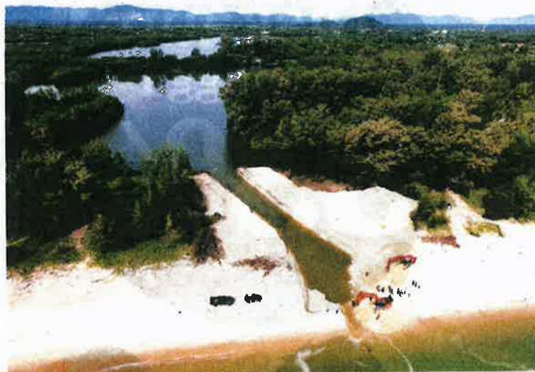
KAWASAN kuala Sungai Semerak, Pasir Puteh yang digali semula untuk menyelamatkan ternakan akuakultur di lagun sungai tersebut.
