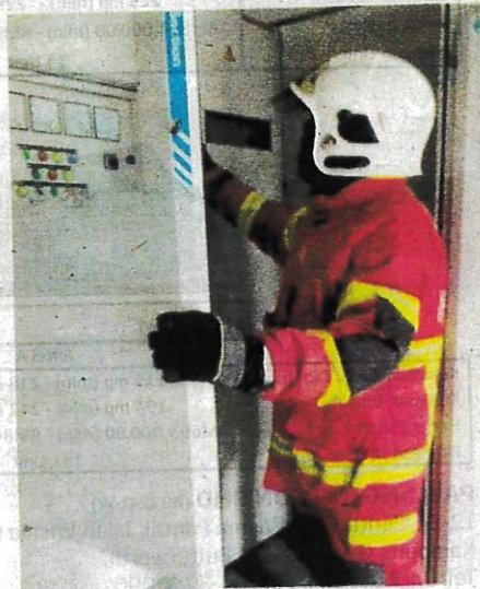
Anggota bomba menjalankan pemeriksaan di bilik elektrik di Menara LPP Jalan Sultan Salahuddin pada Selasa.
