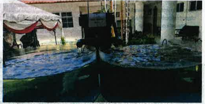
WASTETRONIC yang menggabungkan aktiviti pembuangan sisa kumbahan secara manual kepada sistem automatik yang dikawal mengikut mode operasi injap elektrik air masuk dan air keluar dengan menggunakan PLC (Program Logic Computer).
