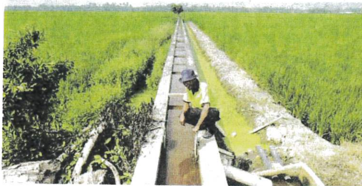
SAIPOP Bahri Sahlan meninjau dan menunjukkan pintu saluran air yang masuk ke dalam petak dari palong dekat sawahnya di Kampung Sawah Sempadan, Tanjong Karang di Kuala Selangor, Selangor. - MINGGUAN/ SADDAM YUSOFF
