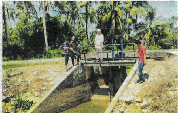
Penternak ikan air tawar Kampung Padang Durian menunjukkan paip sepanjang 50 meter yang digunakan untuk mengepam air dari telaga tiub ke tali air.
