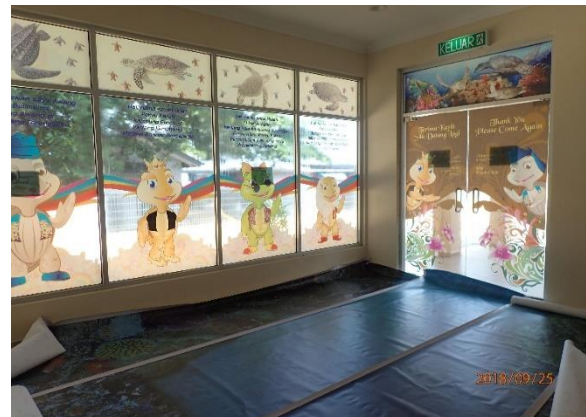
Kemasan Lantai 'Vynil Digital 3D Sticker' Yang Masih Belum Dipasang
