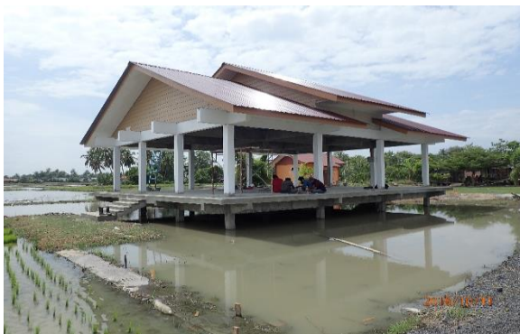
Dinding Kaca Yang Masih Belum Dipasang
