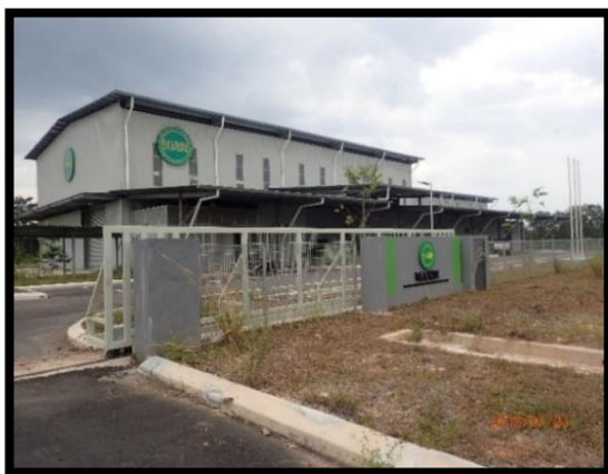
Pandangan Sisi Depan Kilang
