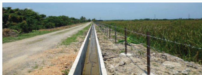
Jalan pertanian, tali air dan pagar yang telah siap.
