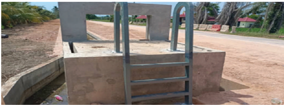
Drainage End Control (DEC) yang telah siap.
