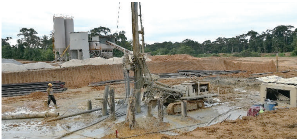
Kerja – kerja pemasangan micropile di Pier 6
