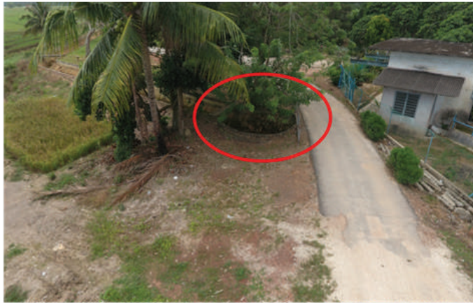
Keadaan 'Pump Sump' Sediada
