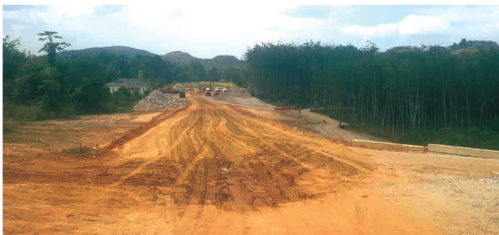
Jalan sambungan di CH600 ke CH 875
