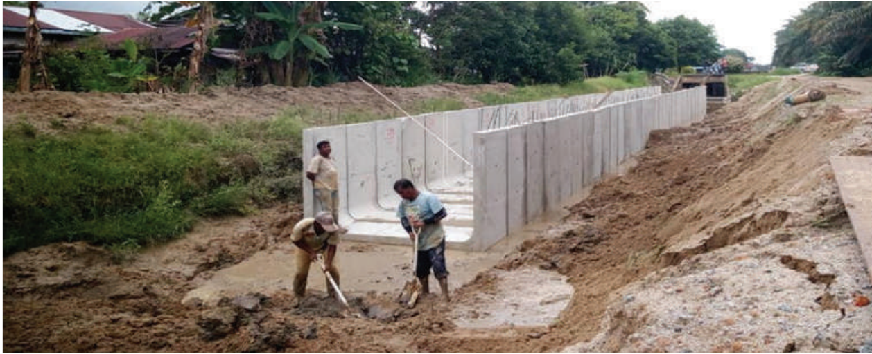
Kerja-Kerja Pemasangan U-Canal Saiz 2.4x1.8m Taliair 1
