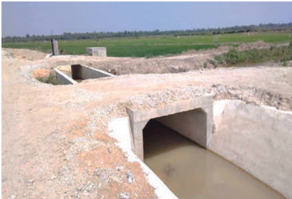
Struktur open flume di CH 1625
