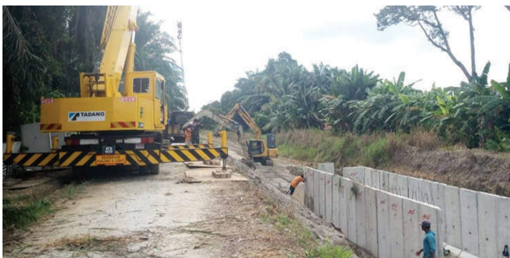
Kerja-Kerja Pemasangan U-Canal Saiz 3.6x2.7m Taliair 5
