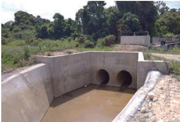
Struktur secondary offtake di CH 0
