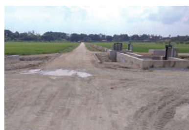
Strukturinverted syphon di C2
