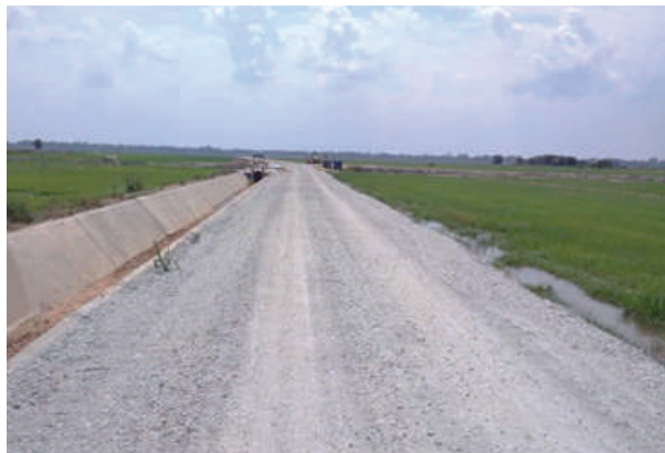
Pembinaan jalan ladang
