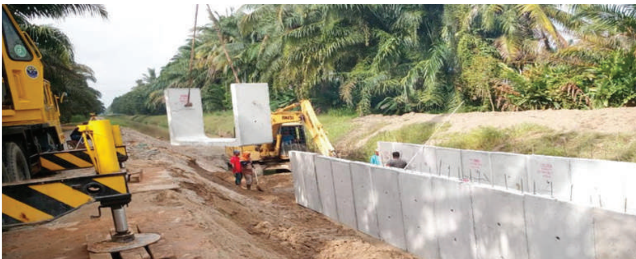
Kerja-Kerja Pemasangan U-Canal Saiz 2.4x1.8m Taliair 1
