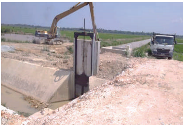
Struktur offtake di CH 825
