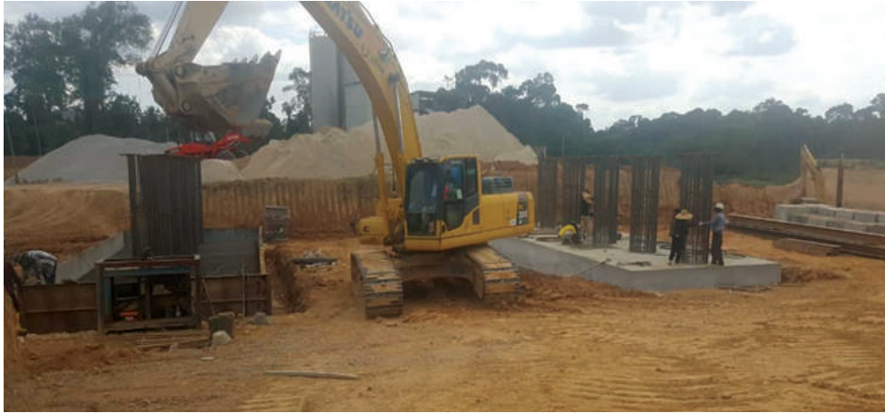
Pier 5 & 6 dalam pembinaan
