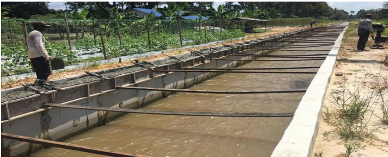
Kerja-Kerja Pembinaan Capping Beam U-Canal Saiz 2.4x1.8m Taliair 1
