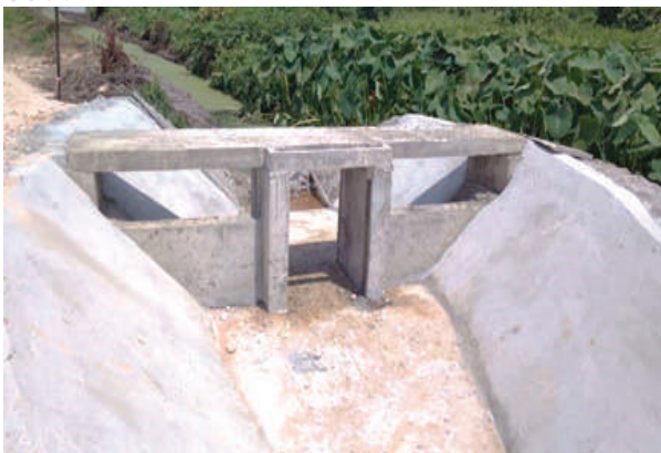
Struktur Irrigation End Control di CH2650
