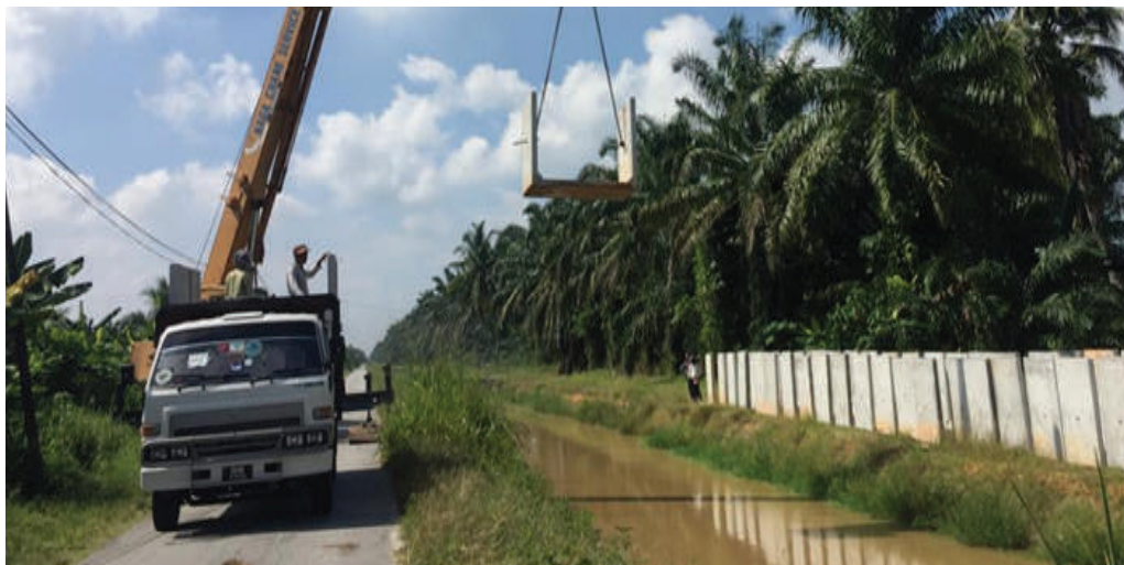
Kerja-Kerja Pemasangan U-Canal Saiz 2.4x1.8m Taliair 1
