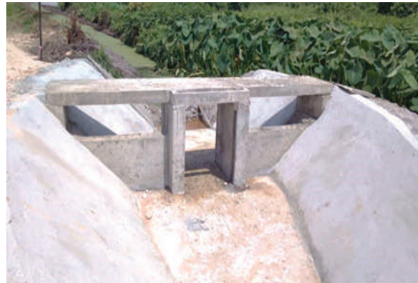
Struktur open flume di CH 1625
