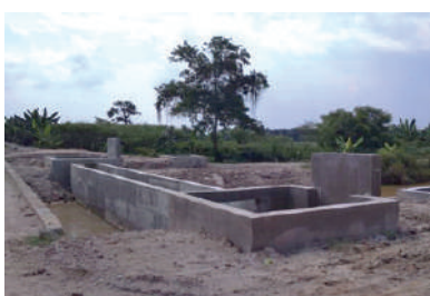
Struktukopen flume di lineE3-E4
