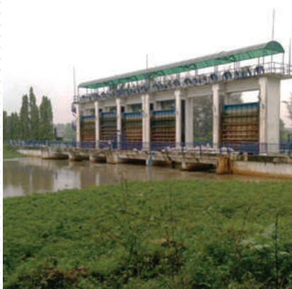
TCG yang telah siap dipasang
