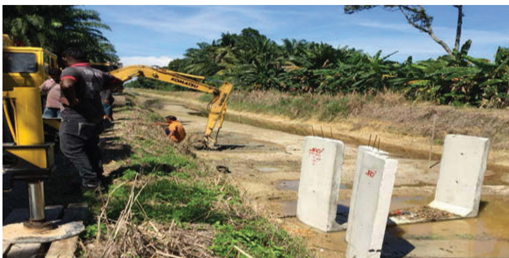
Kerja-Kerja Pemasangan U-Canal Saiz 2.4x1.8m Taliair 1
