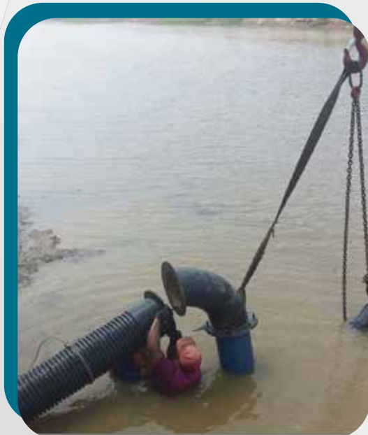
Pemasangan Pam Air Semasa Kekurangan Bekalan Air
