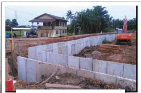
Kerja-Kerja Pemasangan U-Drain
