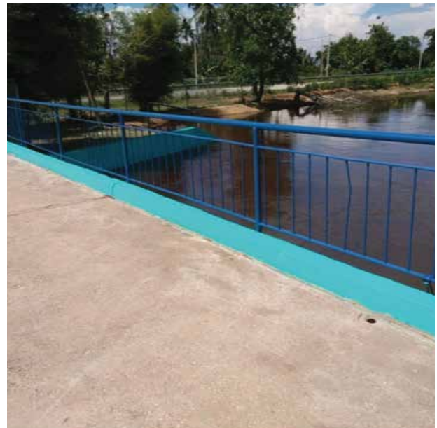
kerja-kerja menaiktaraf stesen telemetri dan mengecat semula serta lain-lain kerja yang berkaitan di Regulator Sungai Leman.
