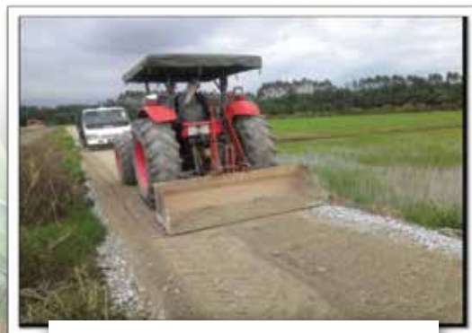
kerja-kerja menaiktaraf jalan ladang
