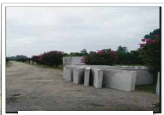
kerja-kerja penstabilan tebing
